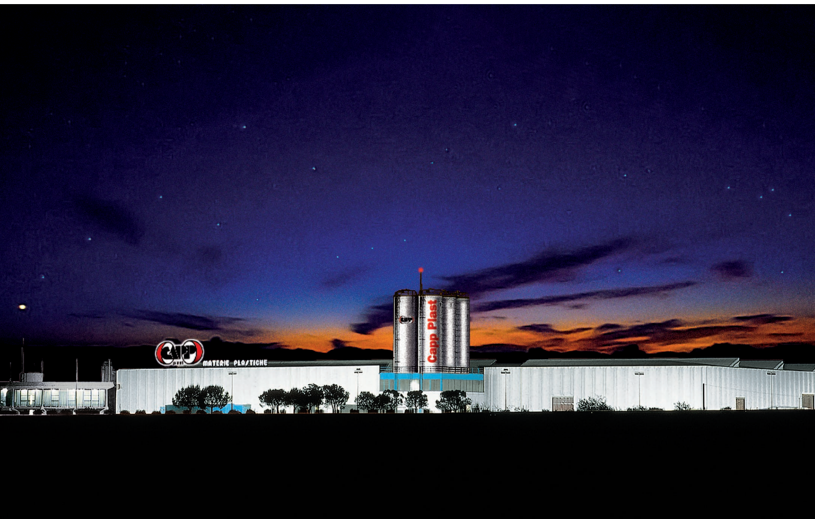
Sito produttivo di Capalle, Firenze
